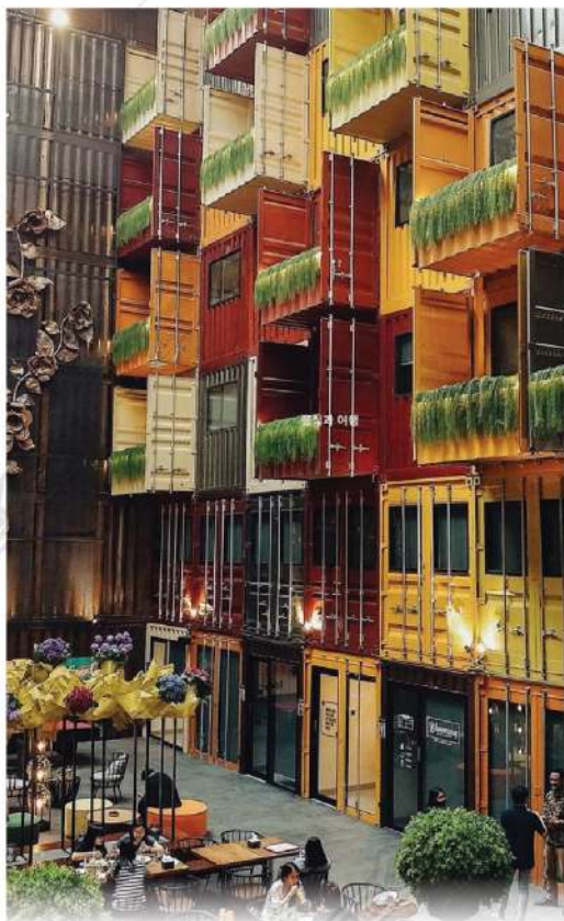
QUBIKA BOUTIQUE HOTEL - BSD TANGERANG
