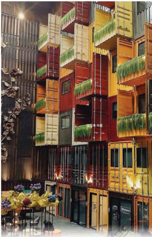
QUBIKA BOUTIQUE HOTEL - BSD TANGERANG
